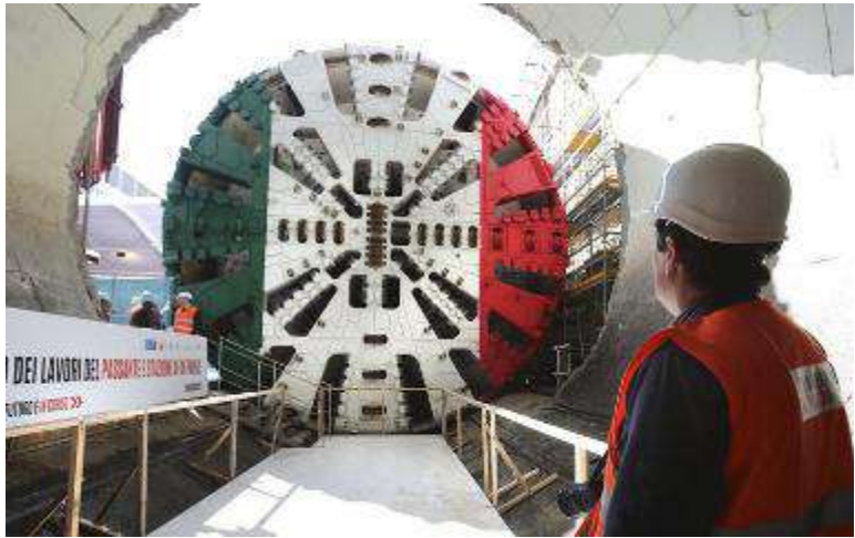
La fresa Iris incaricata di scavare per sette chilometri nel ventre di Firenze
